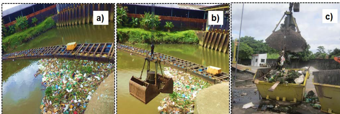
Figura 3: a) resíduos retidos na barreira flutuante localizada no canal do Uma; b) Captura mecanizada dos resíduos retidos; c) Acondicionamento temporário em contêineres
